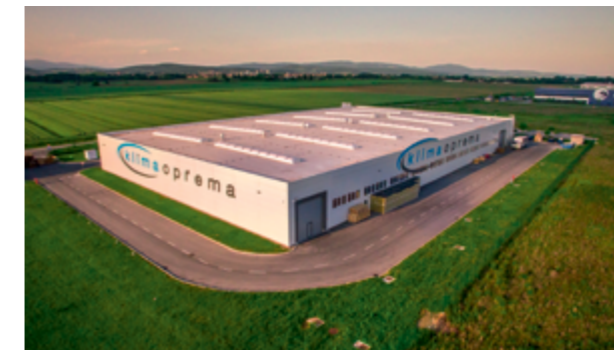
Slika 1. Prvi dio projekta, hala 1
