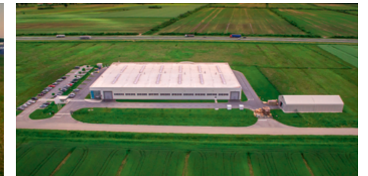
Slika 2. Prvi dio projekta, hala 1
